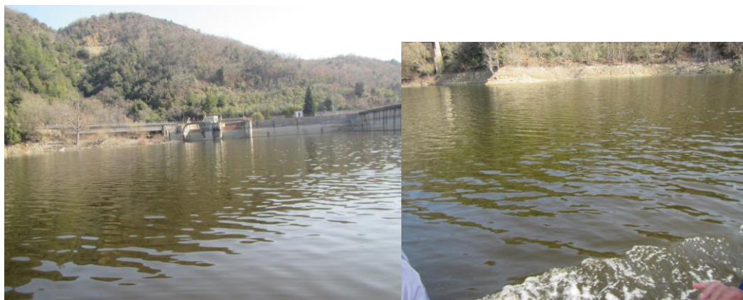
Stazione 1 diga del Pertusillo presso sbarramento
